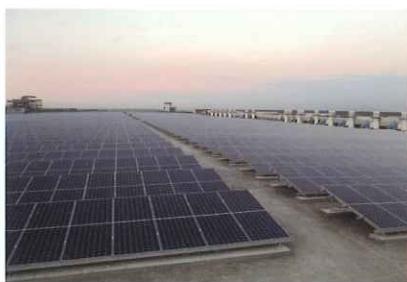
コンクリート基礎。
